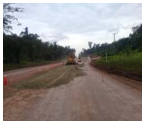
Penghamparan chip agregat layer 2 Sta 7+280 s.d 7+930
