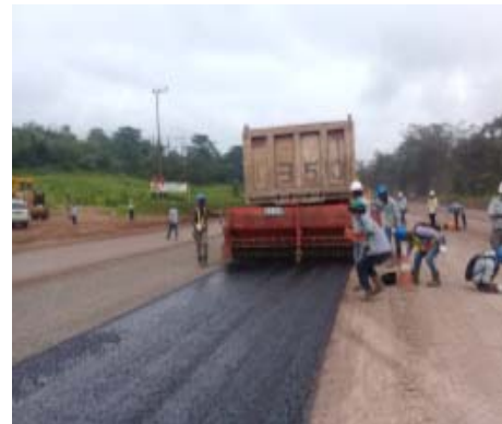
Penghamparan chip agregat layer 2 Sta 7+280 s.d 7+930
