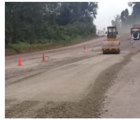
Pemadatan chipseal layer 2 Sta 7+280 s.d 7+930
