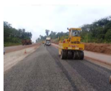
Pemadatan chipseal layer 2 Sta 7+280 s.d 7+930
