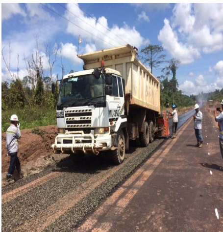
Penghamparan aggregate untuk chipseal
