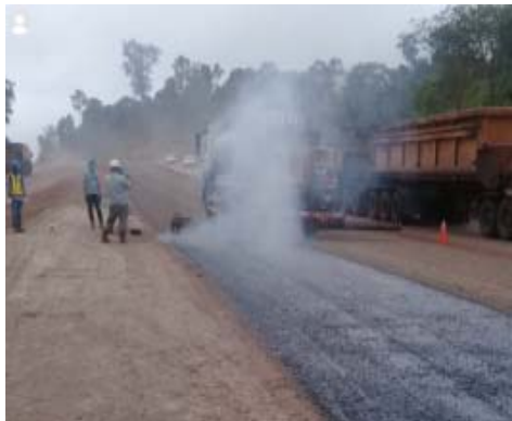
Penyemprotan aspal layer 2 Sta 7+280 s.d 7+930
